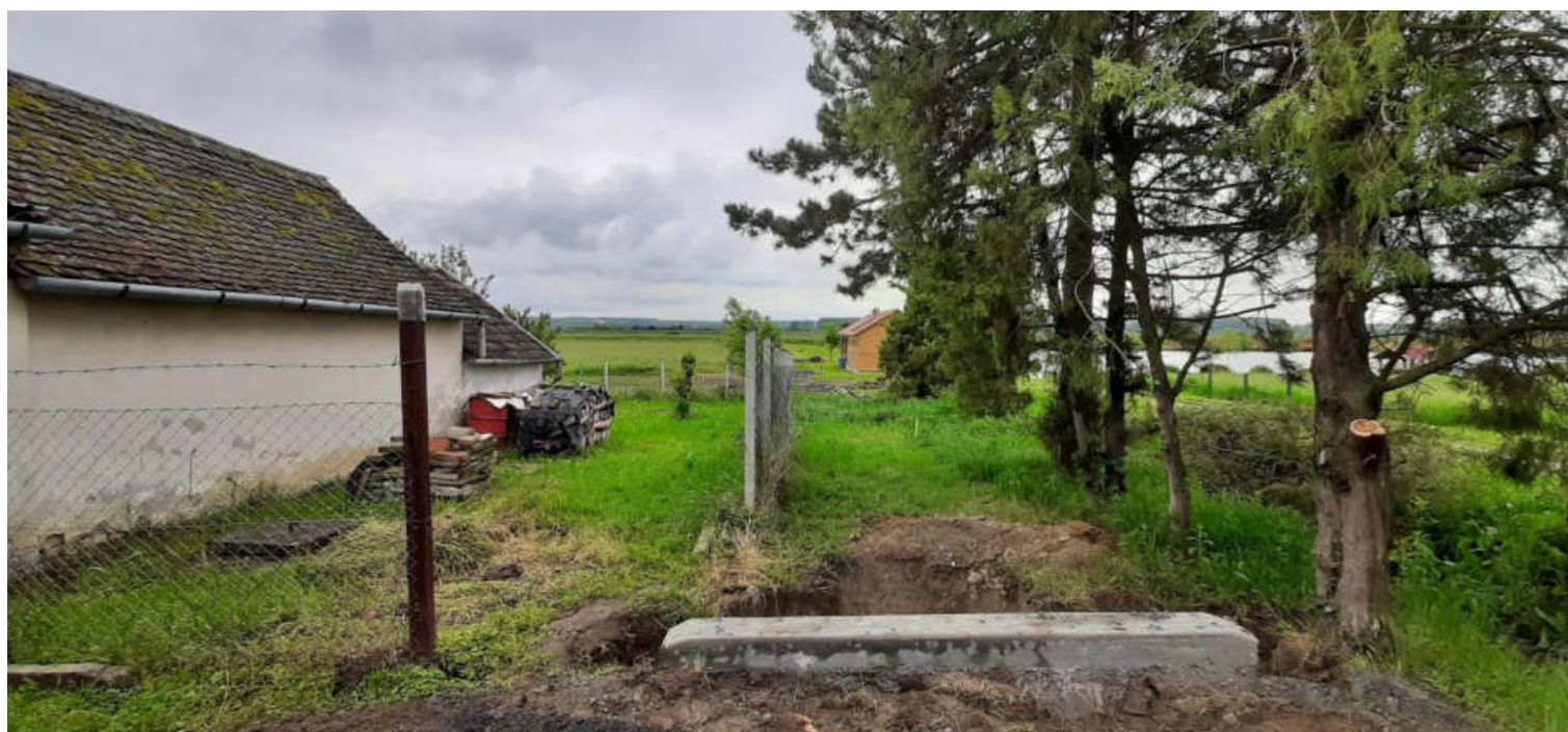
Épülő új csapadékvíz csatorna áteresze
