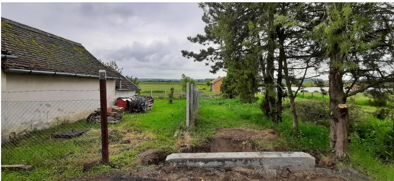
Épülő új csapadékvíz csatorna áteresze
